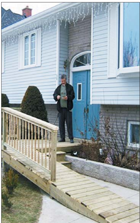
계단 구조였던 정문을 오르막길 형태로 만들어 거동이 느린 노인들이 천천히 걸어다닐 수 있도록 개조한 모습. 폭을 넓히면 휠체어로도 오르내릴 수 있게 설계했다.
