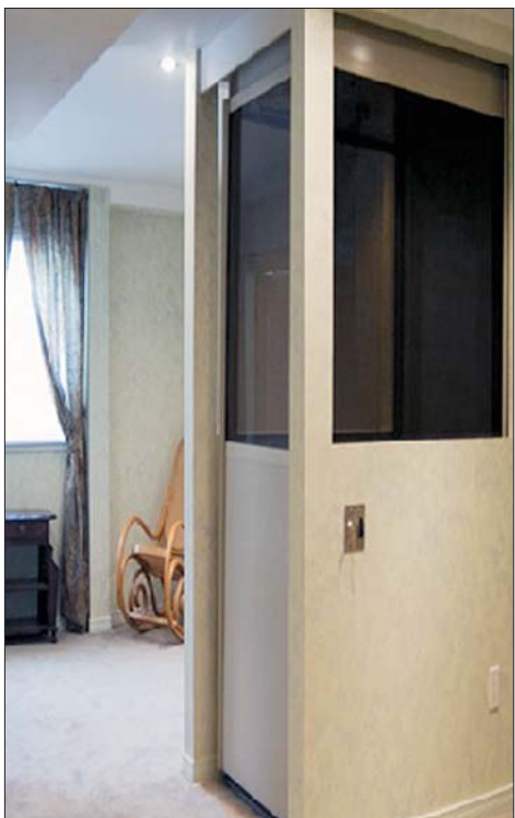
다층 주택 내부를 수직으로 연결하는 간이 엘리베이터를 설치한 모습. 근력이 부족한 노인들이 무거운 짐을 실어날라 수 있도록 만들었다. <사진 제공=릴라이어블리빙>
